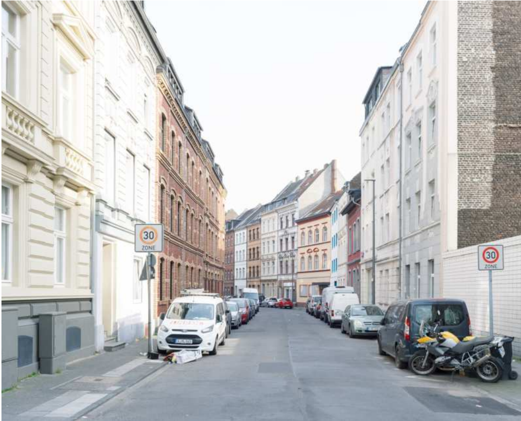
Gründerzeitbauten im Blockrandverbund, Mülheim
