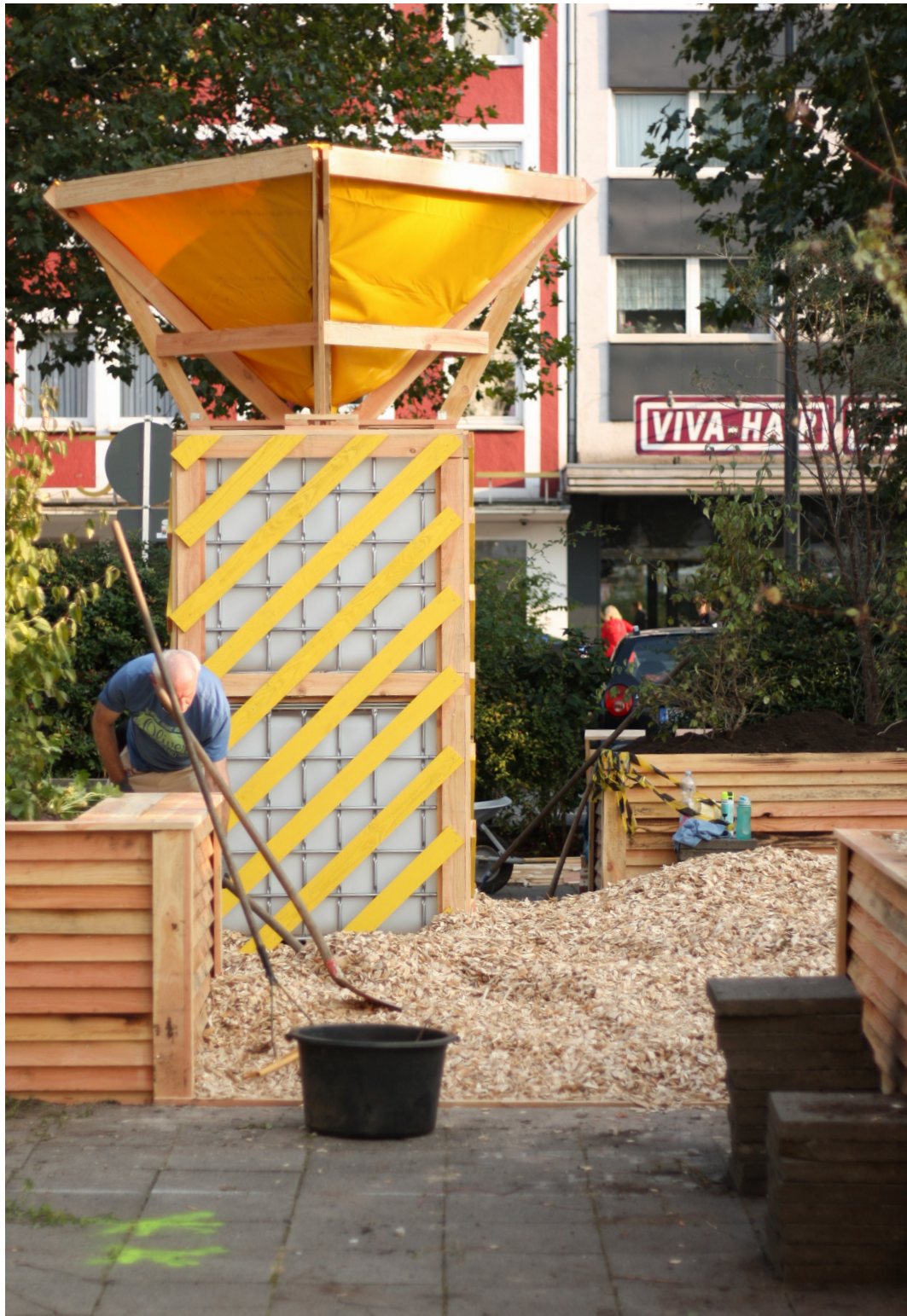
Hackschnitzel bilden den neuen Bodenbelag im Bereich der Flächenentsiegelungen
